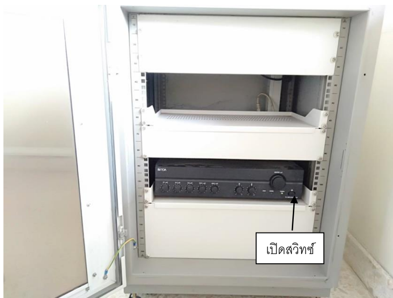
ภาพที่ 50 ตู้แร็คเครื่องเสียงห้องเรียน (สำหรับห้องที่มีเครื่อง Visualizer) อาคารเทพ พงษ์พานิช
